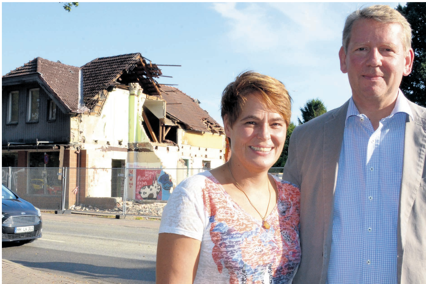
Anke und Sönke Wulff freuen sich aber auf den Neubau des Wohn- und Geschäftshauses an der Segeberger Chaussee
